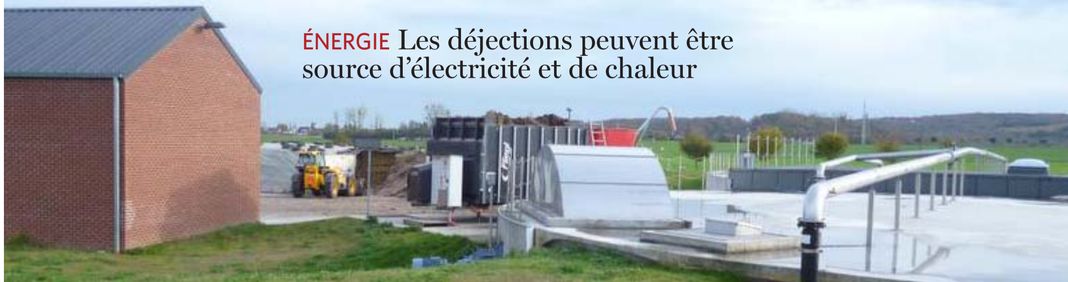
L'infrastructure de biométhanisation d'Aiseau-Présles pourvoit tous les bâtiments communaux en électricité, eau chaude et chauffage. © D.R.
