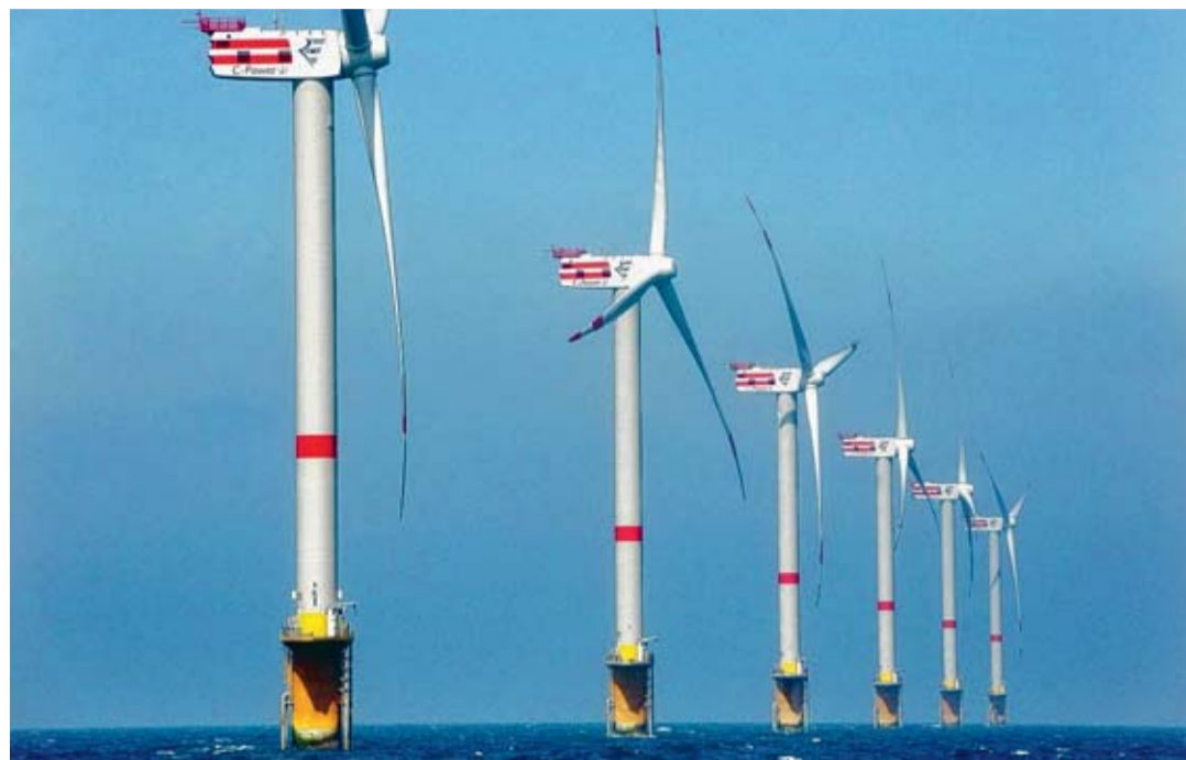
Ces nouvelles batteries pourraient effacer la difficulté à stocker l'électricité, le principal inconvénient des modes de production intermittente, comme l'éolien et le photovoltaïque. © BELGA.
