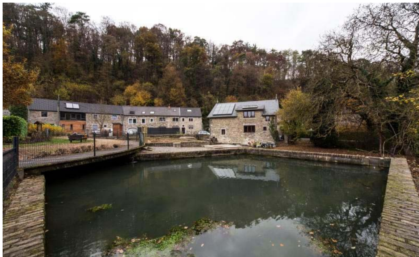
La turbine hydroélectrique, enterrée, est actionnée grâce à l'eau provenant de la « Résurgence du Moulin ». © MICHEL TONNEAU.
